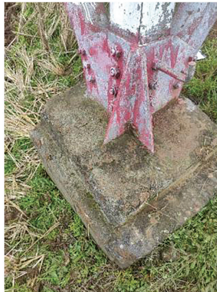
(d) Column D foundation
