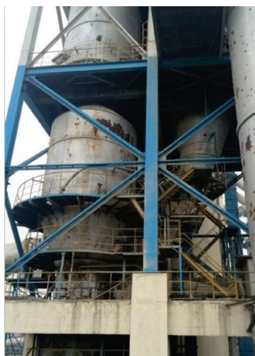
Fig. 1 Precalciner
